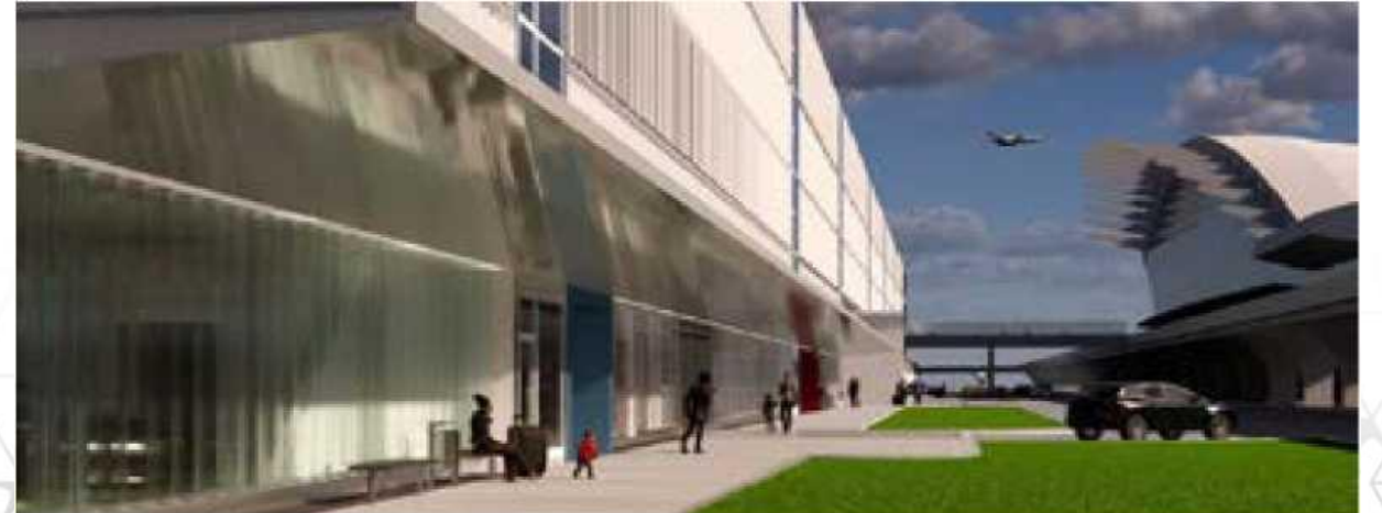
"Vnukovo-Cargo" posta ve kargo kompleksinden görselleştirme
